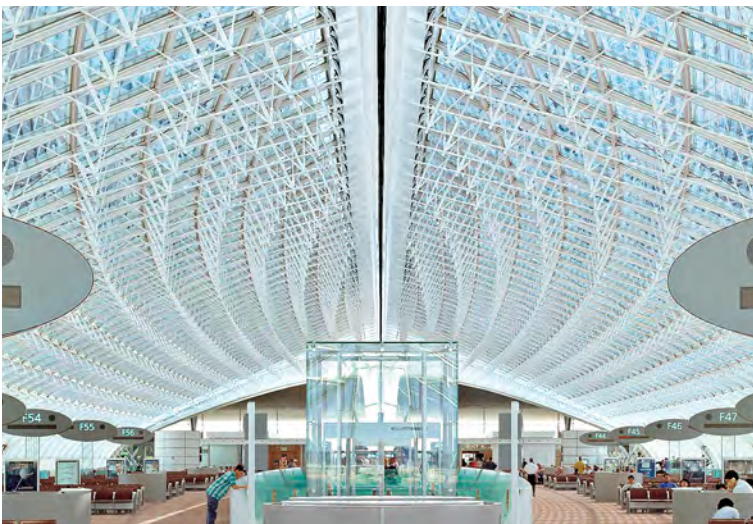
In de luchthaven Charles-de-Gaulle te Parijs, is een trapeziumvormige roestvast stalen plaat met 68 mm perforaties gemonteerd aan de buitenkant van de glazen vertrekhal om het interieur te beschermen tegen de zon.
