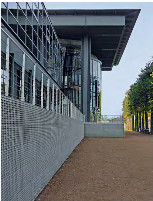
Gelaste roestvast stalen tralies zijn gebruikt als bescherming tegen de zon aan de Mediatheek in de Franse stad Sélestat.
