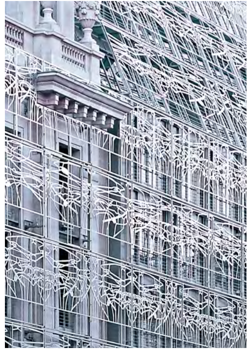
Deze sluier van lasergesneden 12 mm roestvast stalen panelen, die dienen als versiering, bedekken de verschillende delen van het gebouw van het Ministerie van Cultuur te Parijs.
