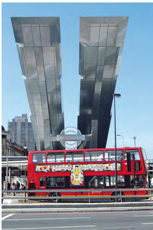
Bij de Vauxhall Cross Bus Interchange in London is een oppervlak gebruikt met een patroon, waardoor de noodzaak tot reinigen minder wordt.
