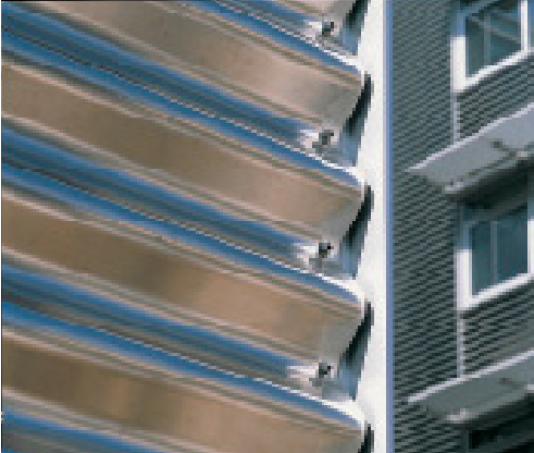
Geprofileerde roestvast stalen bekleding met zichtbare roestvast stalen bevestigingen op regelmatige afstanden.
