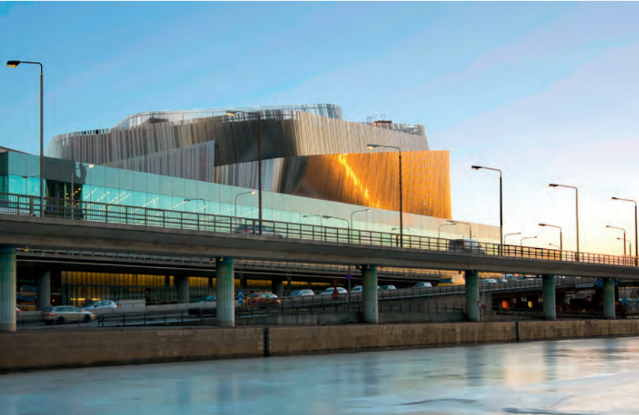
Markant erhebt sich die mit nichtrostenden Stahl-lamellen verkleidete Kongresshalle über dem Wasser und den umgebenden Verkehrsstraßen.
