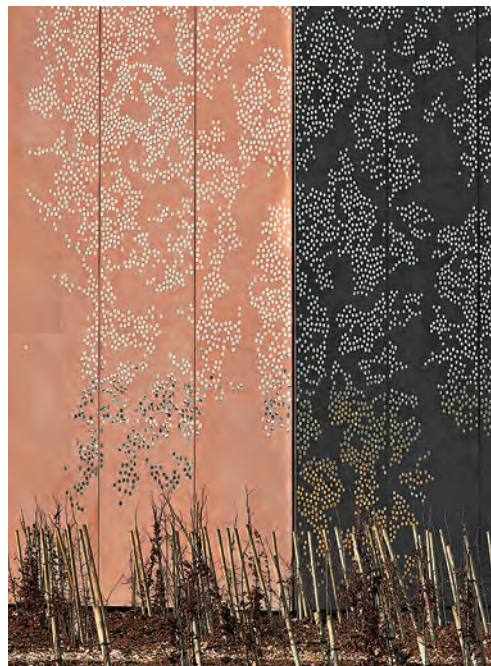
Das über alle Fassaden durchgängige Muster löst sich nach unten hin auf und schafft so den Übergang von dem eingefärbten Beton zur Erde.
