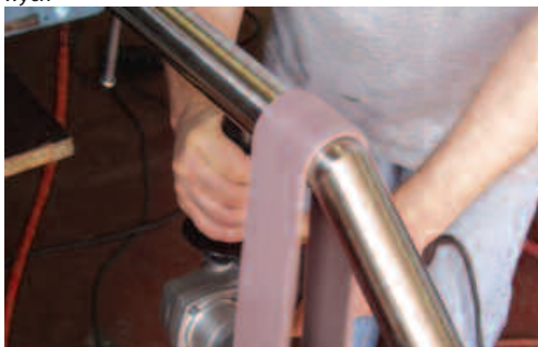
Operacje wykończeniowe z łatwymi w użyciu, zasilanymi ręcznymi narzędziami. Wewnętrzny ostry kąt połączenia jest wciąż widoczny ze spawem.
