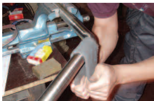
Ręczne dopasowywanie całej poręczy do wykończenia poprzez formowanie gładkiego połączenia między dwoma rurami
