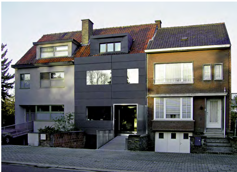
Parte del nuevo porche de entrada de acero inoxidable sobresale de la fachada de hormigón reforzado con fibra aislante.
