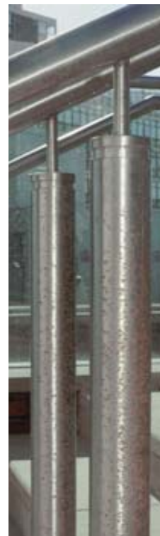
Rdzewienie zanieczyszczeń żelaznych w okresie użytkowania stali nierdzewnej jest bardzo nieestetyczne, a jego usuwanie czasochłonne i kosztowne.
