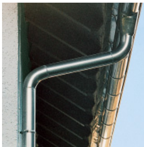
Sistemi di gronda in acciaio inossidabile con finitura standard di acciaieria: 2B lucida (a destra) e 2D opaca (a sinistra).
