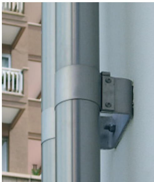
Borstad rostfritt avvattningssystem som går genom interiören på en flygplatsterminal
