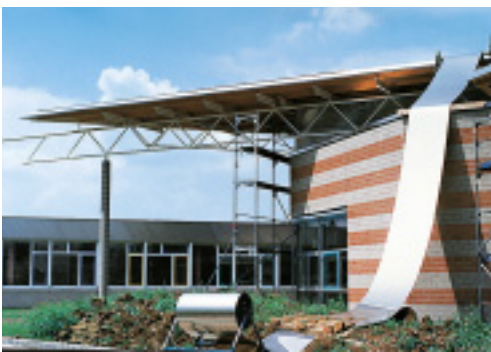
Vor Ort wurden die Edelstahlbahnen auf die jeweils benötigte Länge geschnitten.
