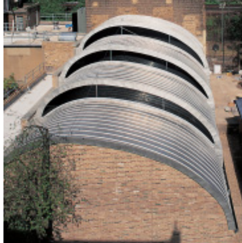
Edelstahl Rostfrei bildet die Außenhaut dieser ungewöhnlichen Dachform.
