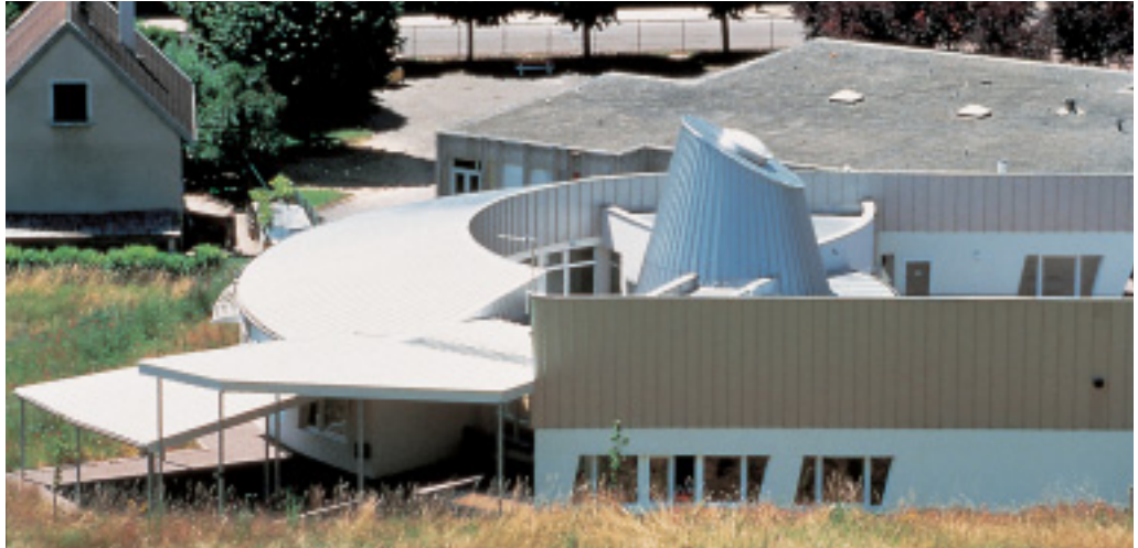
Bei Dacheindeckung und Verkleidung der hohen Attikazonen in der Fassade wurde dasselbe Material, mattgrauer Edelstahl Rostfrei, eingesetzt.
