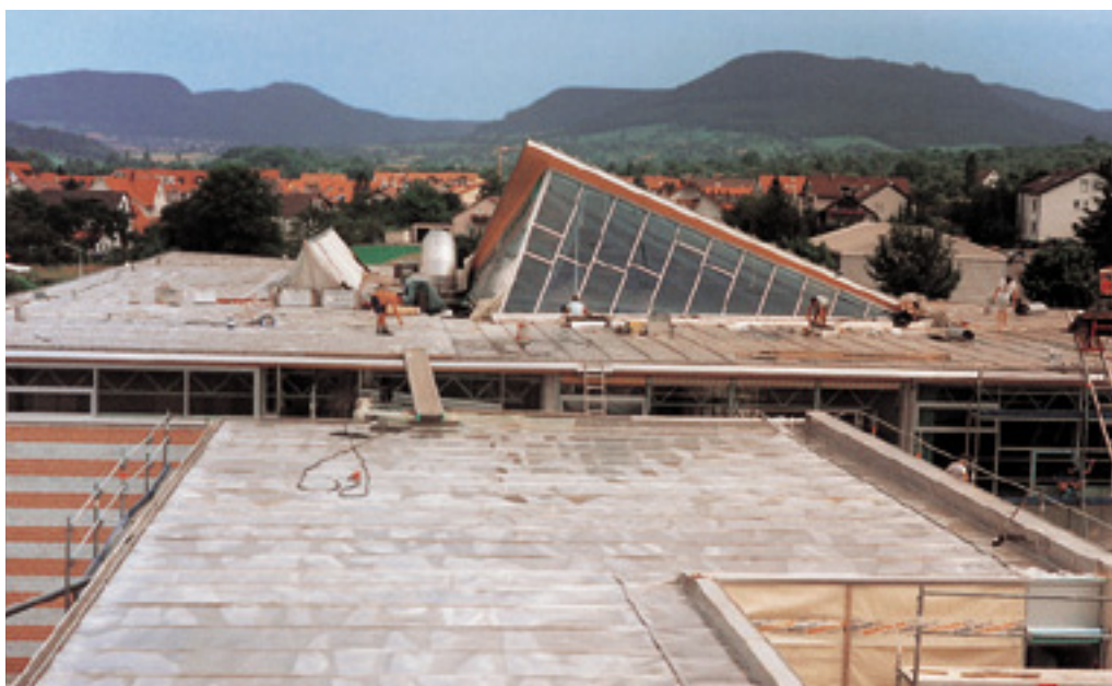
Det sömsvetsade rostfria taket före plantering (till höger) och efter (bakom till höger).
