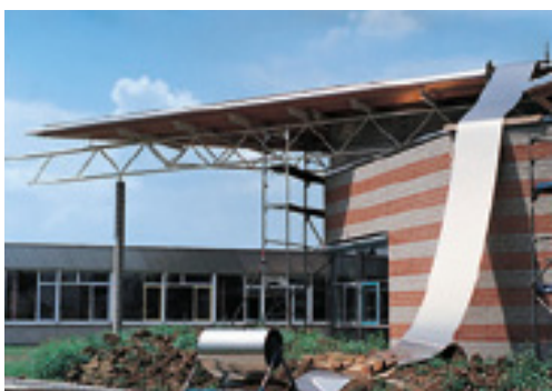
Det rostfria bandet klipps i önskade längder på byggnadsplatsen.
