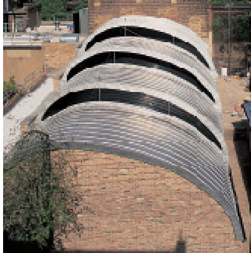
Rostfritt stål används till täckning av detta ovanligt formade tak.
