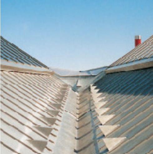
Takkonstruktionen ventileras genom ventilationskupor i rännaldalen.
