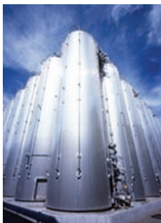
Jeden způsob, jak vyřešit věkovitý problém koroze nádob pro fermentaci soji, je vyrobít nové zařízení z vysokolegované superaustenitické korozivzdorné oceli (u těchto nádrží se jedná o chráňnou značku obsahující 23% chromu, 25% niklu a 5,5% molybdenu). Fotografie: Nippon Yakin Kogyo Co. Ltd.
