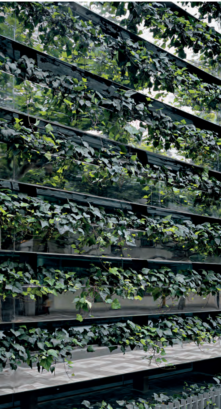
Le essenze vegetali nelle fioriere a specchio trasformano la facciata in vetro e acciaio in una parete verde.
