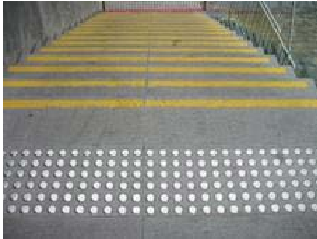
不锈钢触摸式地面指路系统更耐久，更具有吸引力。 照片：欧洲不锈钢发展协会，布鲁塞尔，比利时
