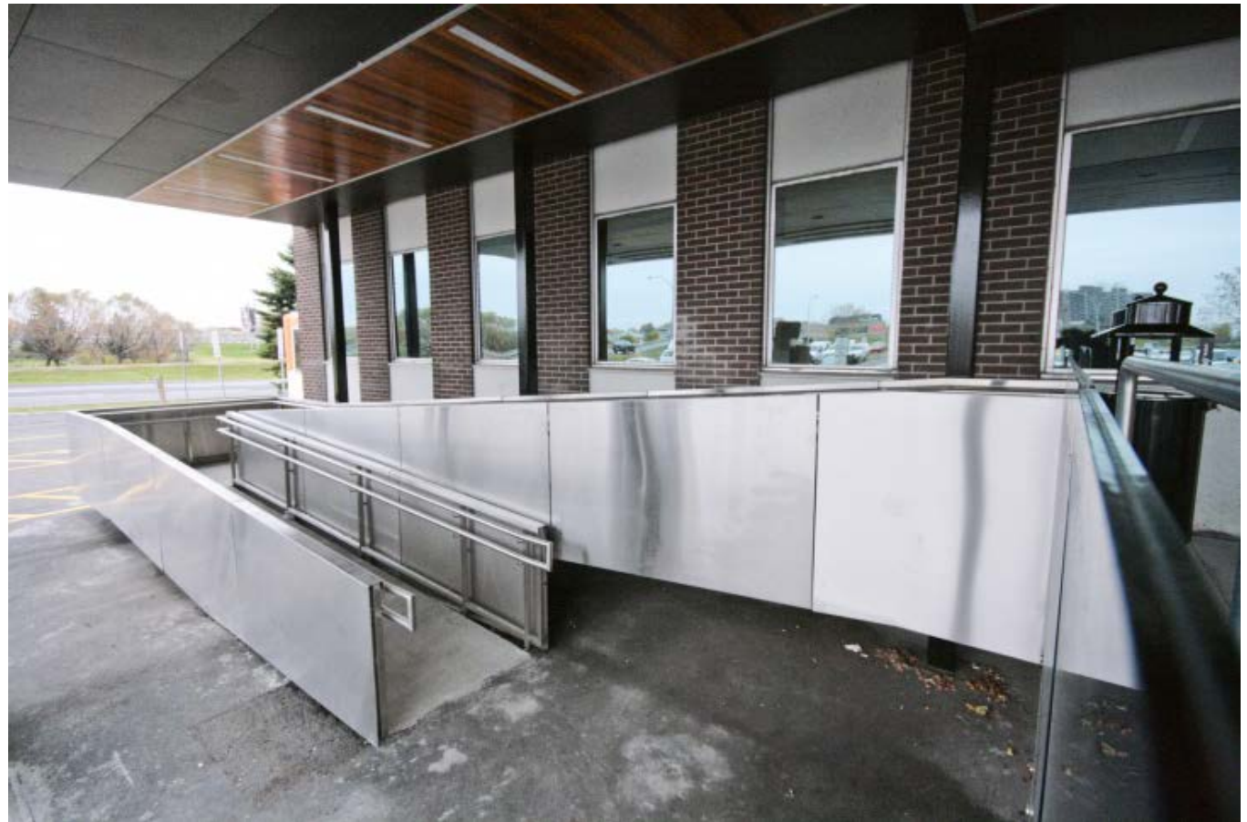
Aço inoxidável tipo 316 é particularmente resistente à corrosão, sendo também o mais apropriado para ambientes onde o sal para degelo é utilizado no inverno rigoroso e para aplicações próximas ao mar. Projeto de Bättig de Ohoto, Lavolette Trois-Rivières, Quebec, Canadá
