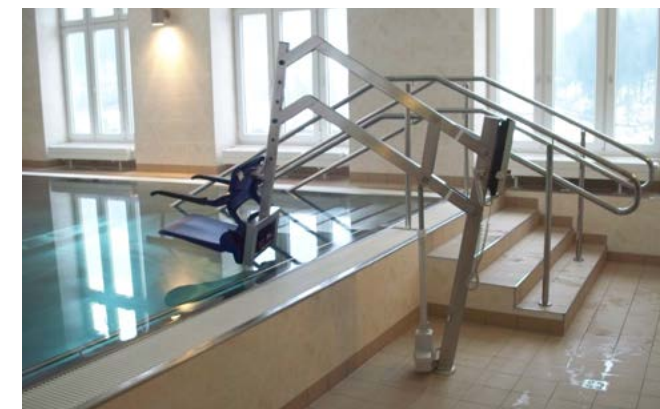
Piscinas internas estão entre os ambientes mais corrosivos, o que requer materiais resistentes à corrosão. Fotos: Hoyer Lifter, Butzbach, Alemanha
