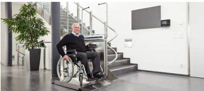
Em alguns modelos a guia da plataforma elevatória serve também como um corrimão de uso geral. Foto: Ascendor, Niederwaldkirchen, Áustria
