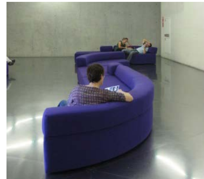
Apesar de seu caráter reflexivo, chapas de aço inoxidável podem ser antiderrapantes, como mostrado na sala de exposições da Caixa Forum em Madrid, Espanha. Foto: Euro Inox, Bruxelas, Bélgica
