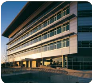
大楼正面幕墙
