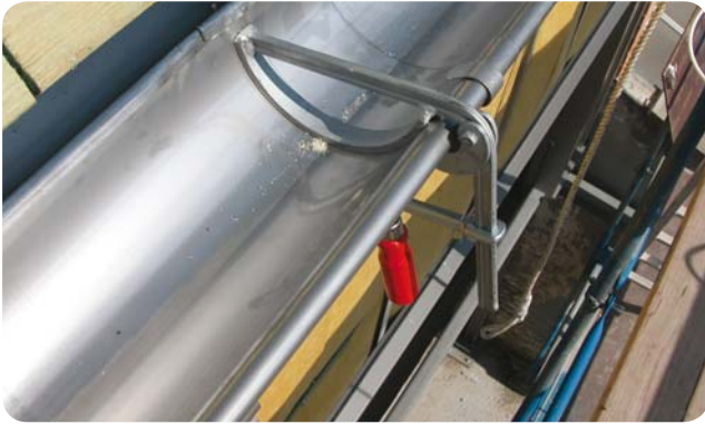
槽接头，镀锌 430Ti 不锈钢板。
