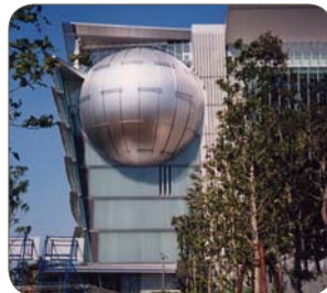
大楼正面幕墙
