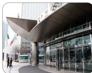
天津，440M 不锈钢，南桥。
