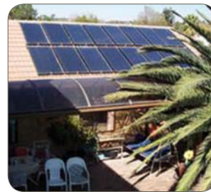
太阳能电池板: 机座和集电极 使用铁素体不锈钢 441/444.
