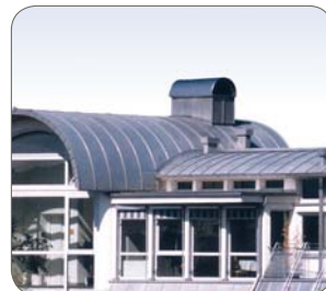
430Ti 不锈钢 (立接缝技术), Ugine & Alz, 奥地利
