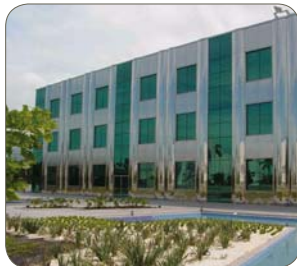
大楼正面幕墙
