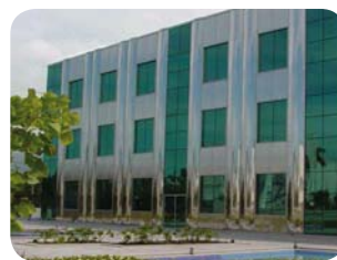
建筑覆层，部分 444 不锈钢，巴西。
