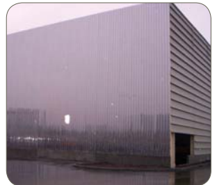
大楼正面幕墙
