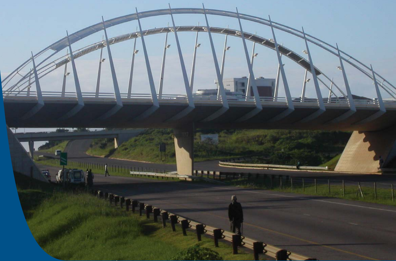
南非德班高速公路钢结构桥， 采用了涂漆的铁素体不锈钢。
