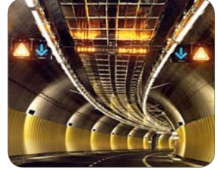
터널 안쪽 벽면 (INNER WALL OF TUNNEL)
