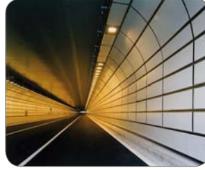
터널 안쪽 벽면 (INNER WALL OF TUNNEL)
