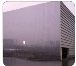
건물 앞면 클래딩 (BUILDING FAÇADE CLADDING)
