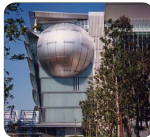
건물 앞면 클래딩 (BUILDING FAÇADE CLADDING)
