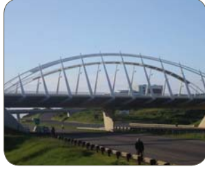
교각의 철강 구조물 (STRUCTURAL STEELWORK OF BRIDGE)
