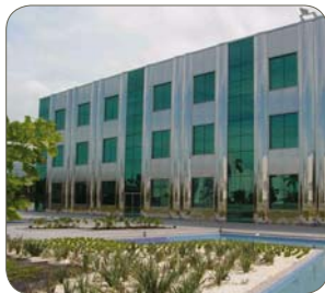
건물 앞면 클래딩 (BUILDING FAÇADE CLADDING)
