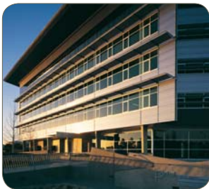
건물 앞면 클래딩 (BUILDING FAÇADE CLADDING)
