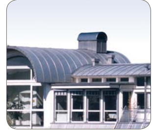
Tipo 430Ti (técnica de "standing seam"), Ugine & Alz, Áustria
