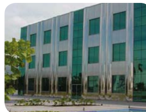
Revestimento parcial em edifício com 444, Brasil.
