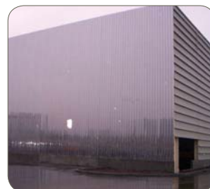
Tipo 1.4526/436, Centro de Serviço de Aço da Ugine & Alz, Arcelor Mittal Stainless, Katowice, Polônia
