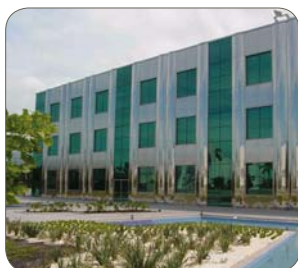
Tipo 1.4521/444 escovado no. 4 (painéis horizontais), Prédio da Vivo, Rio de Janeiro, Núcleo Inox, Brasil (ambiente costeiro)
