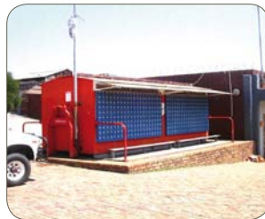
Tipo 1.4003/410, pintado, SASSDA, África do Sul. Os ferríticos para os 'serviços' são geralmente pintados, sempre que a estética for um fator importante a ser considerado.
