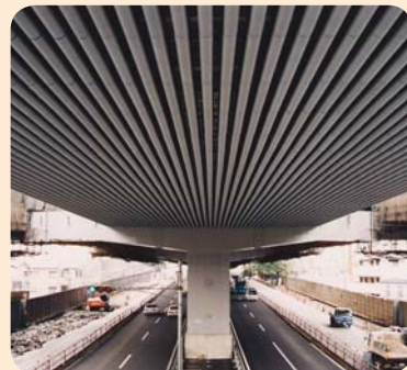
Placa anti-ruídos sob viaduto, Japão.
