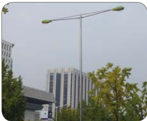
Tipo 1.4510/439, tubo soldado, eletro-polido, KOSA, Seul, Coreia do Sul
