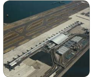
TIPO SUS447J1, Prédio do terminal do Aeroporto Kansai (arquiteto Renzo Piano), JSSA, Osaka, Japão
