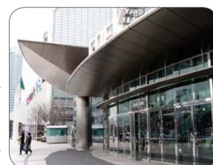
Cobertura em aço inoxidável 444K, na Coreia do Sul
