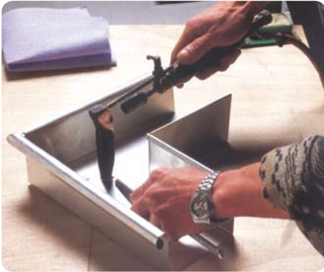
Bir oluğun lehimlenmesi, kolay kapı 430Ti kalite.
