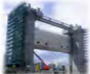
Kotonoura Gate (SUS316LN) Hikata Gate (SUS323L)
