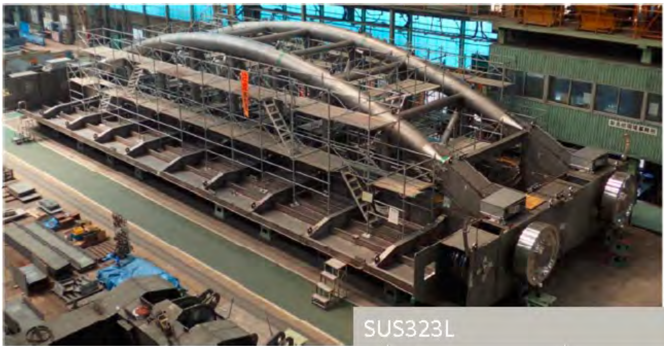
正在修建中的水闸
