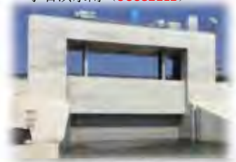
Tsukihama Gate (SUS323L) 月滨水闸 (SUS323L)
