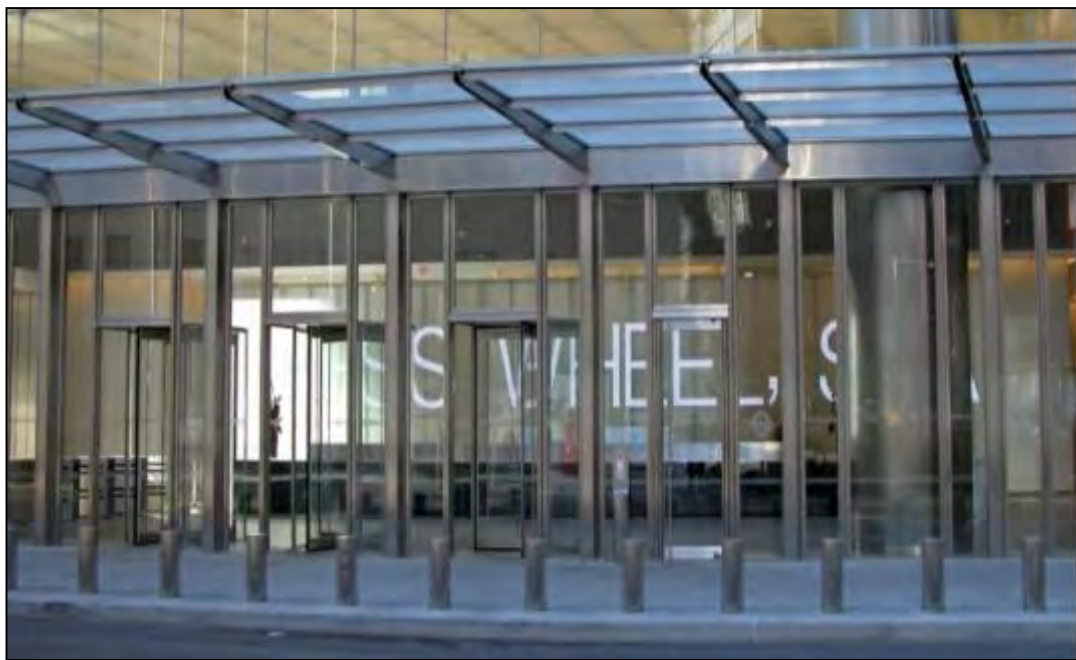
入口遮阳篷抗爆柱，纽约世贸中心七号大楼
