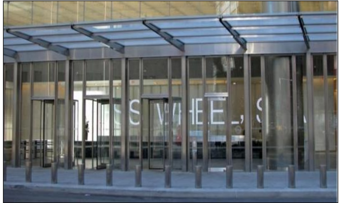
Poteaux résistant aux explosions pour l'auvent de l'entrée du « Seven World Trade Centre », New York
