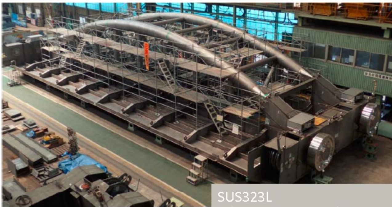
Vue de la barrière en cours de construction
