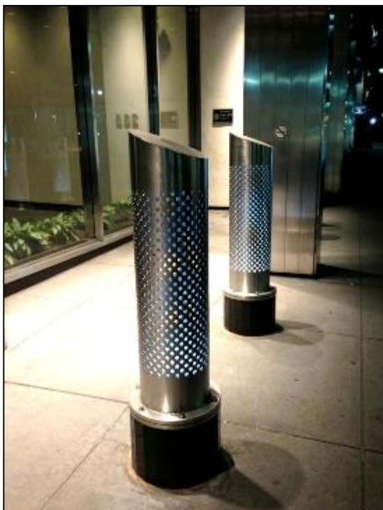
Palo di sicurezza
