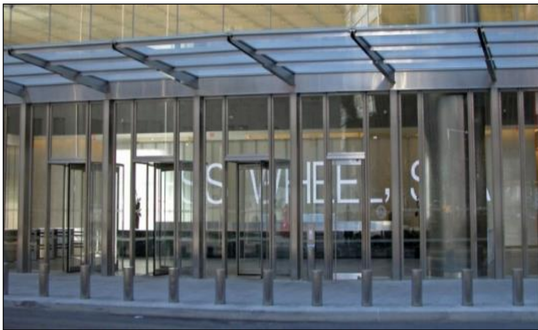
Colonne resistenti allo scoppio nella tettoia d'ingresso, Seven World Trade Centre, New York
