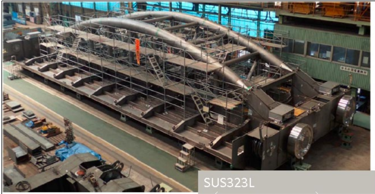
建造中の水門
