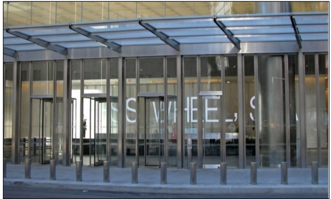
Seven World Trade Center (セブン・ワールド・トレード・センター, ニューヨーク) 入り口天蓋の耐衝撃柱
