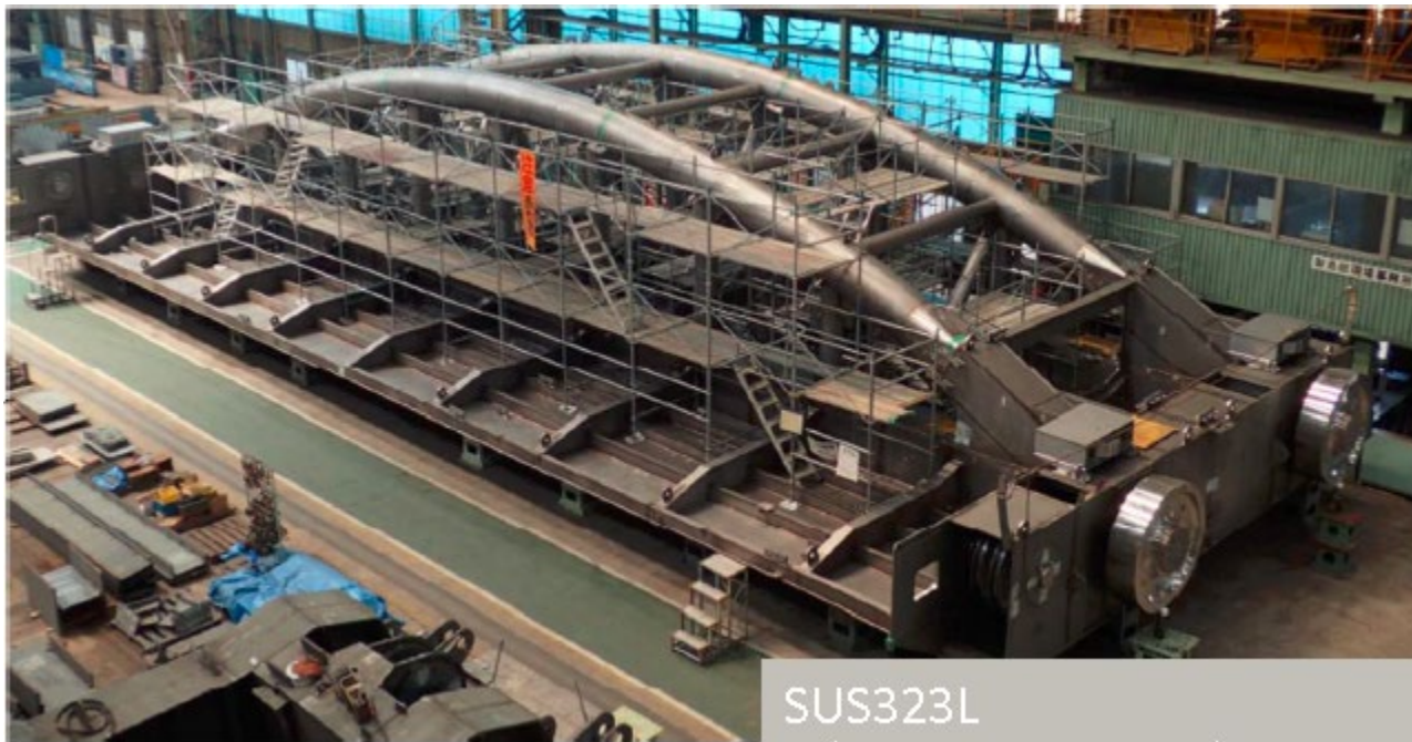
Widok śluzy w trakcie budowy
