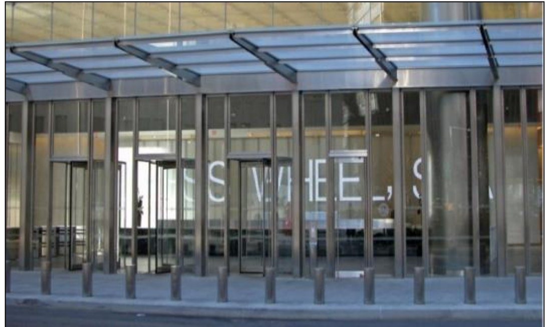
Słupy odporne na wybuch w zadaszeniu przed wejściem, Seven World Trade Centre, Nowy Jork
