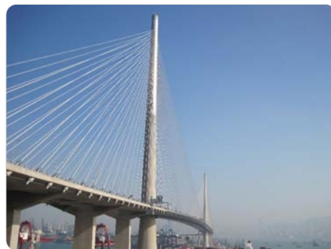
香港昂船洲大桥。 供图: 奥托昆普钢铁公司
