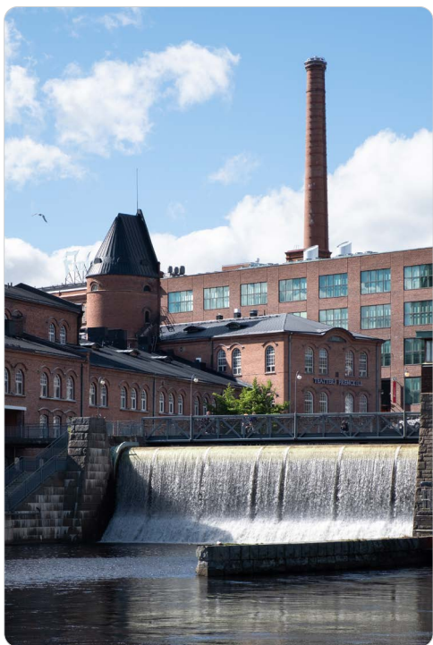
芬兰坦默科斯基河的泄洪闸
