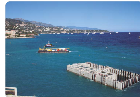
摩纳哥海上扩建项目 供图：布伊吉斯土木工程公司
