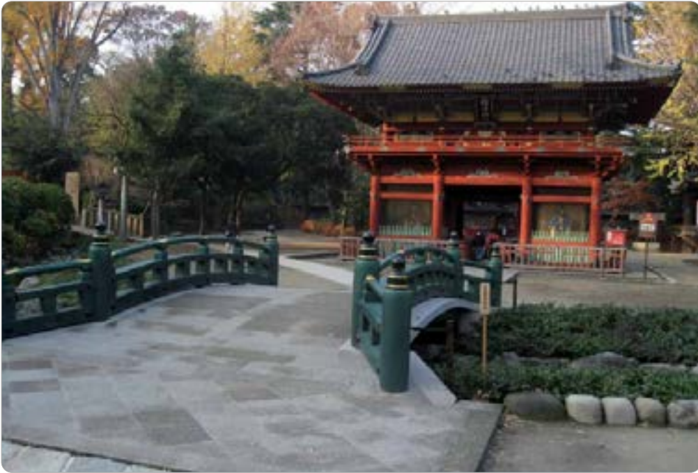
使用410不锈钢筋建造的根津神社桥
