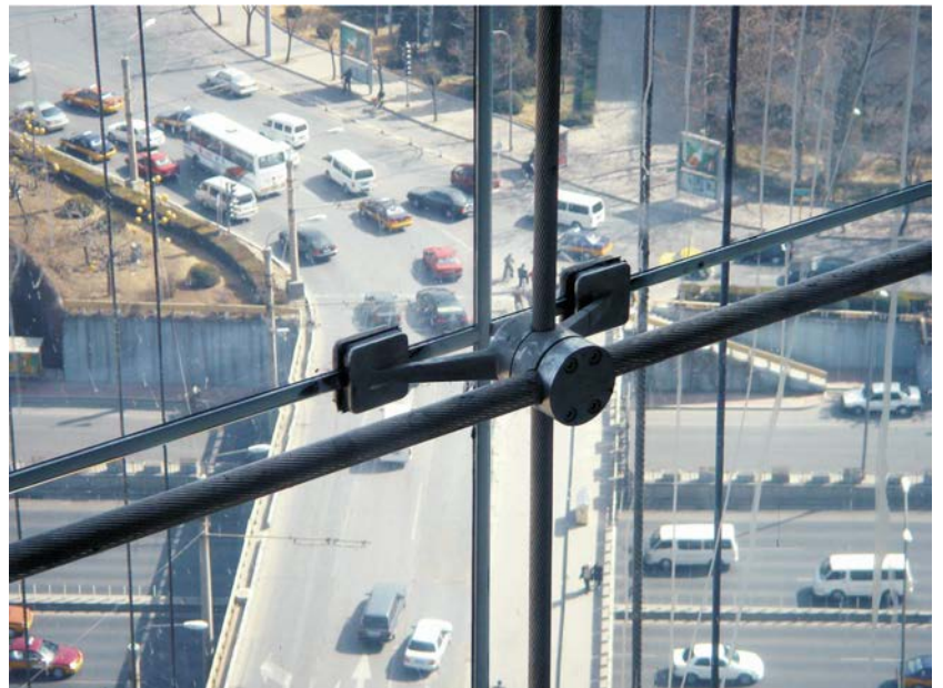
图 6: 不锈钢缆与玻璃之间的连接 (照片来源: Skidmore, Owings & Merrill LLP)
