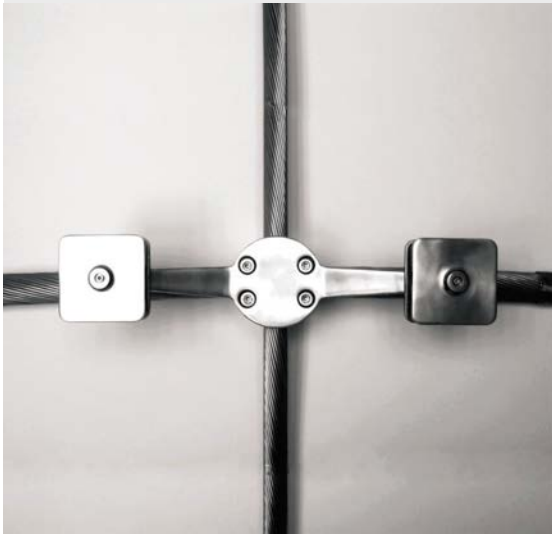
图 4: 安装之前垂直与水平钢缆连接的放大照片 (照片来源: Tim Griffiths, Skidmore, Owings & Merrill LLP)
