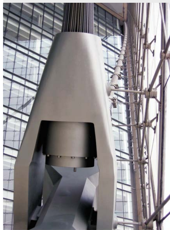
图 7: 与不锈钢缆相连接的铸钢机械摇摆装置 (照片来源: Tim Griffiths, Skidmore, Owings & Merrill LLP)
